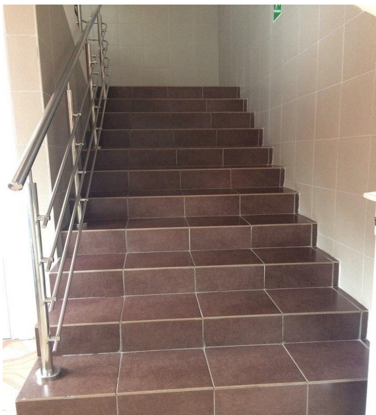
Фото 10 Лестница (внутри здания)
